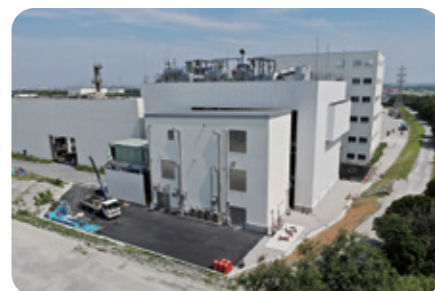
完成した4号焼却炉
