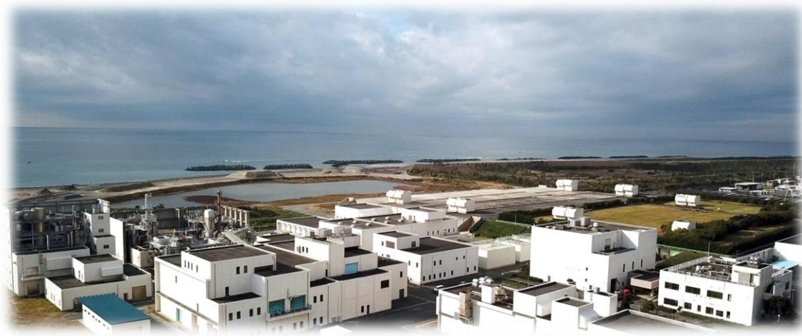
西遠浄化センター
