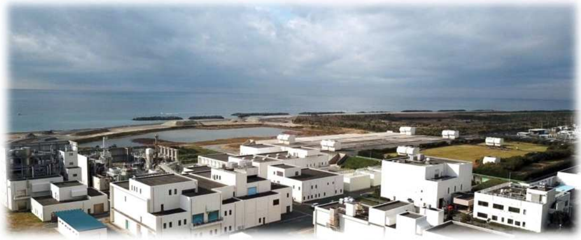
西遠浄化センター
