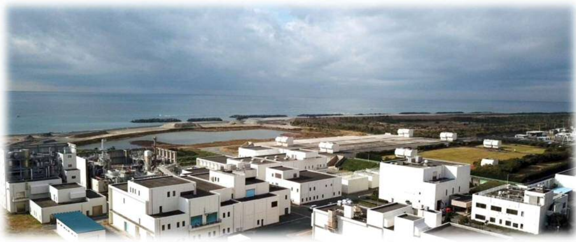
西遠浄化センター
