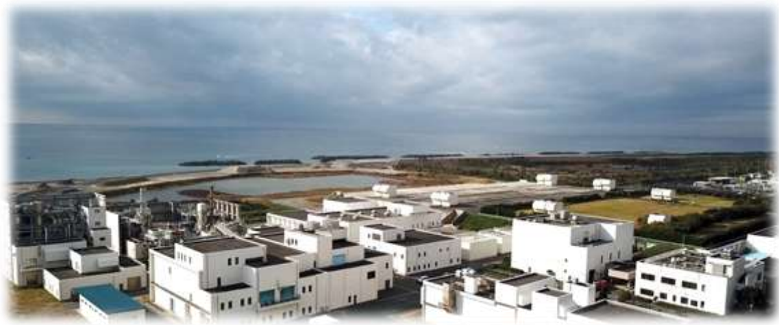
西遠浄化センター
