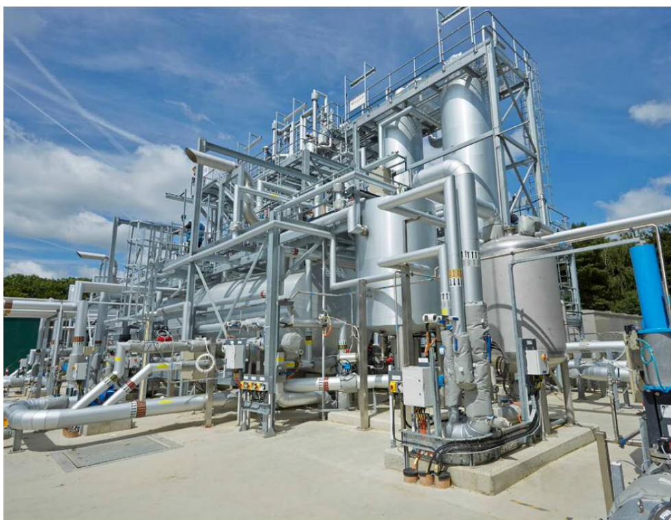
汚泥可溶化設備（イメージ）
