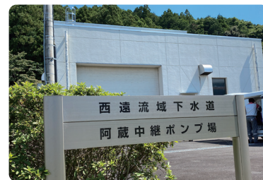
2つの中継ポンプ場のうちの1つ、阿蔵中継ポンプ場
