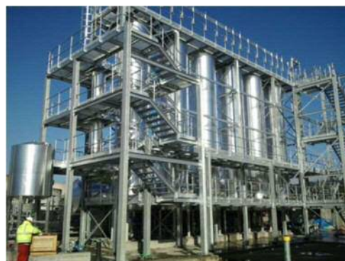
図4 污泥可溶化施設
