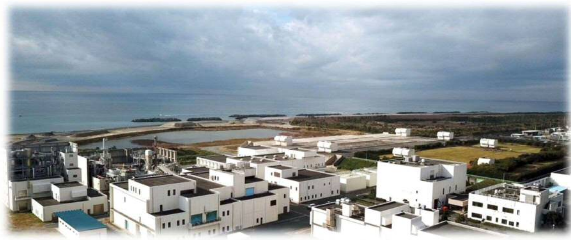
西遠浄化センター
