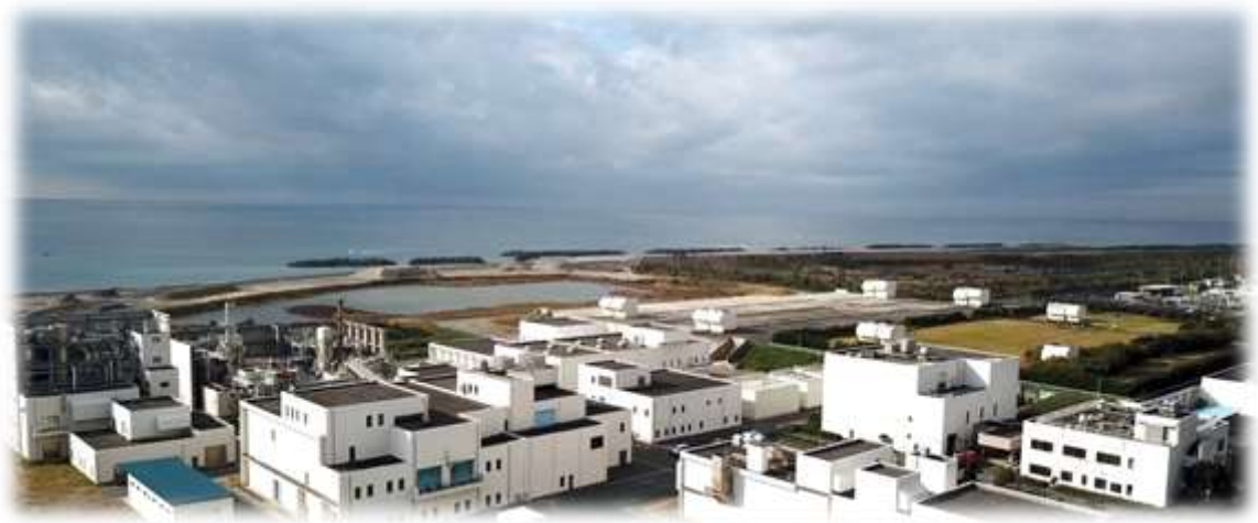
西遠浄化センター
