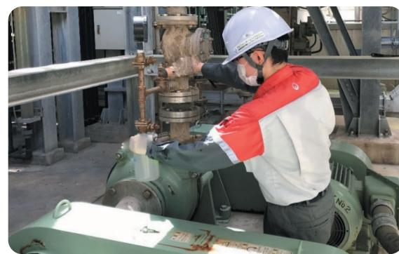
焼却炉から発生する煙に有害物質が含まれているため、水で洗浄した後の排水（洗煙排水）を採水しています
