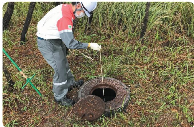
マンホールからの採水時に転落しないよう採水専用の小蓋を取り付けることで、安全対策を施しています
